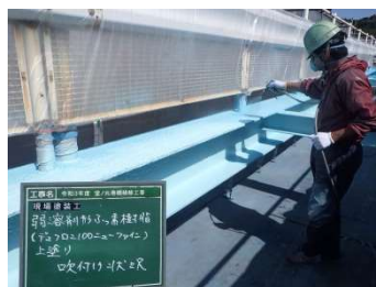
補修状況（塗装工）
