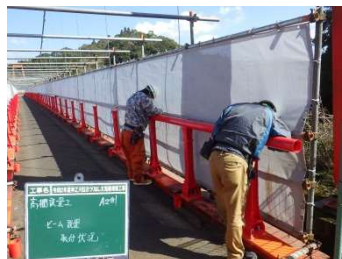
補修状況（高欄設置工）
