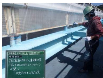
補修状況（塗装工）
