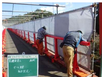
補修状況（高欄設置工）
