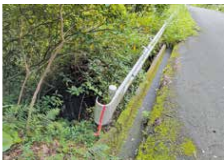
町道松尾線の路肩部
