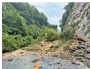
斜面崩落発生現場
