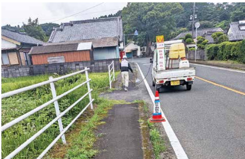
国道 448 号 除草剤散布作業
