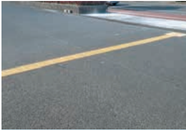
補修済の点字プレート
