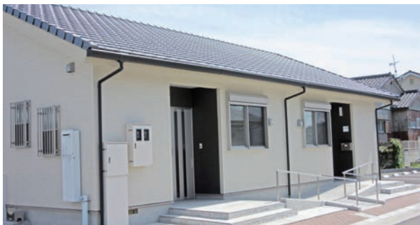
現地建て替えて新しくなった木場住宅
