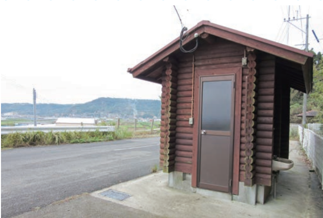
中西自治会にある建屋型のトイレは農業従事者等に広く利用されています。
