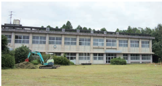
旧宿利原中学校の改修工事が進められています。
