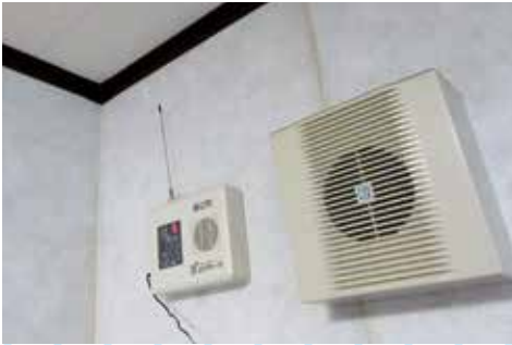
個別受信機は、多くの家庭で天井近くに設置されています。
