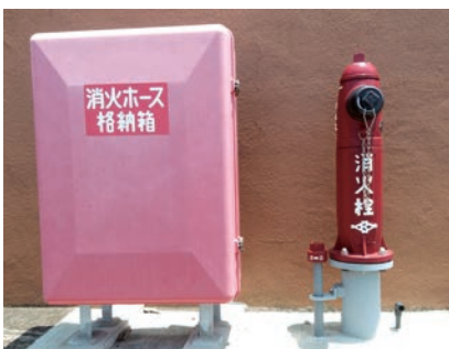
地上式消火栓の拡充が望まれます
