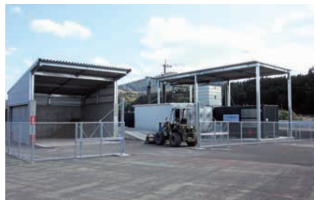
木質バイオマス熱電供給施設の外観（完成）
