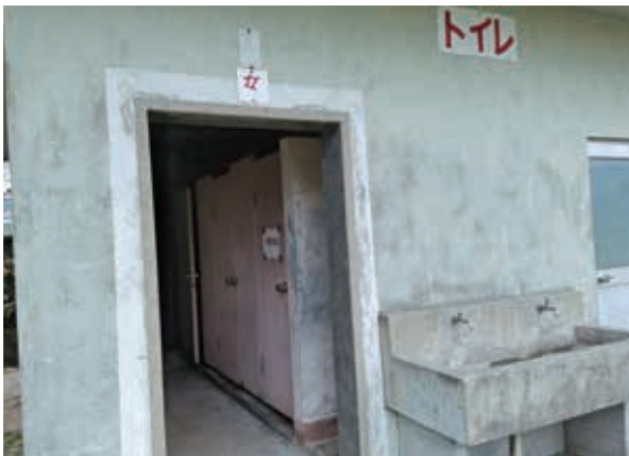
すべての利用者にとって使いやすいトイレへの改修が望まれます
