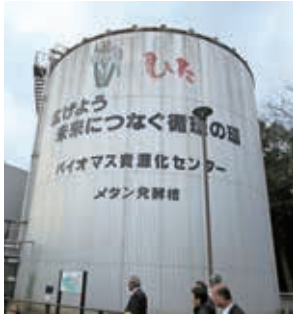
メタン発酵槽
