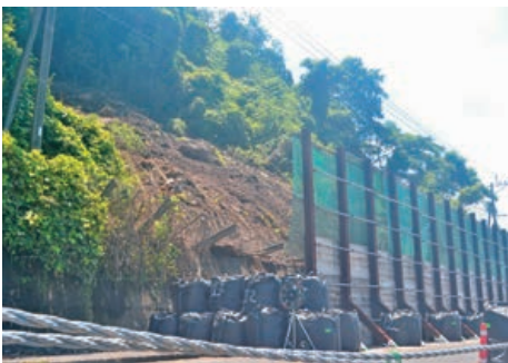
国道 269 号線城ヶ崎の土砂崩れ現場
