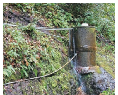
集落水道の給水槽
