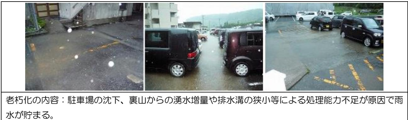
老朽化の内容：駐車場の沈下、裏山からの湧水増量や排水溝の狭小等による処理能力不足が原因で雨水が貯まる。
