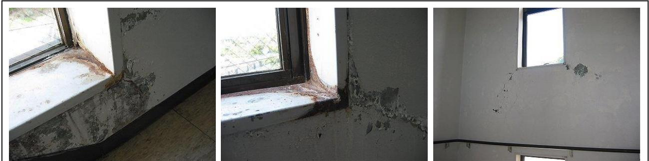
老朽化の内容：外壁にひび割れ、雨漏り。
