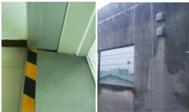
老朽化の内容：旧増築棟の沈下がおきている。また、外壁にひび割れが生じている。
