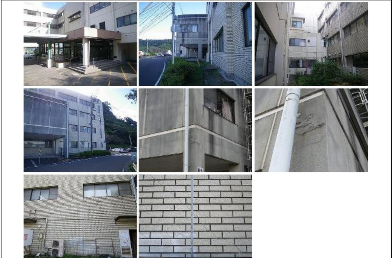
老朽化の内容：平成 27 年度タイル壁打診調査の結果、全面にひび割れや欠損、浮きあり（北・南面一部補修）
