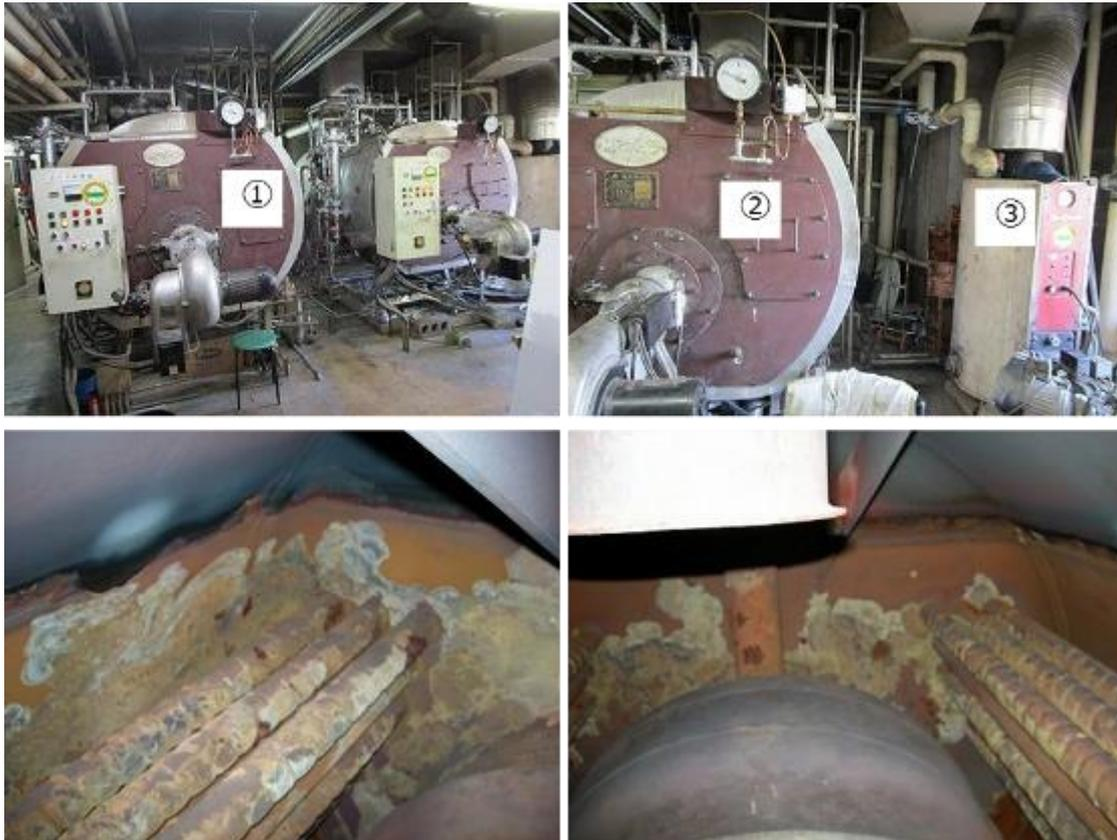
老朽化の内容：昭和 55 年に設置されたもので、腐食・老朽化が進んでいる。
