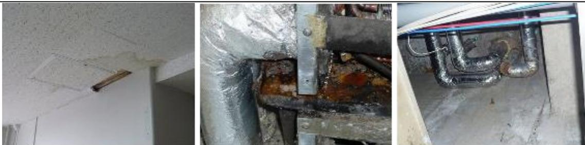
老朽化の内容：3階病室床置き空調器ドレン板劣化
