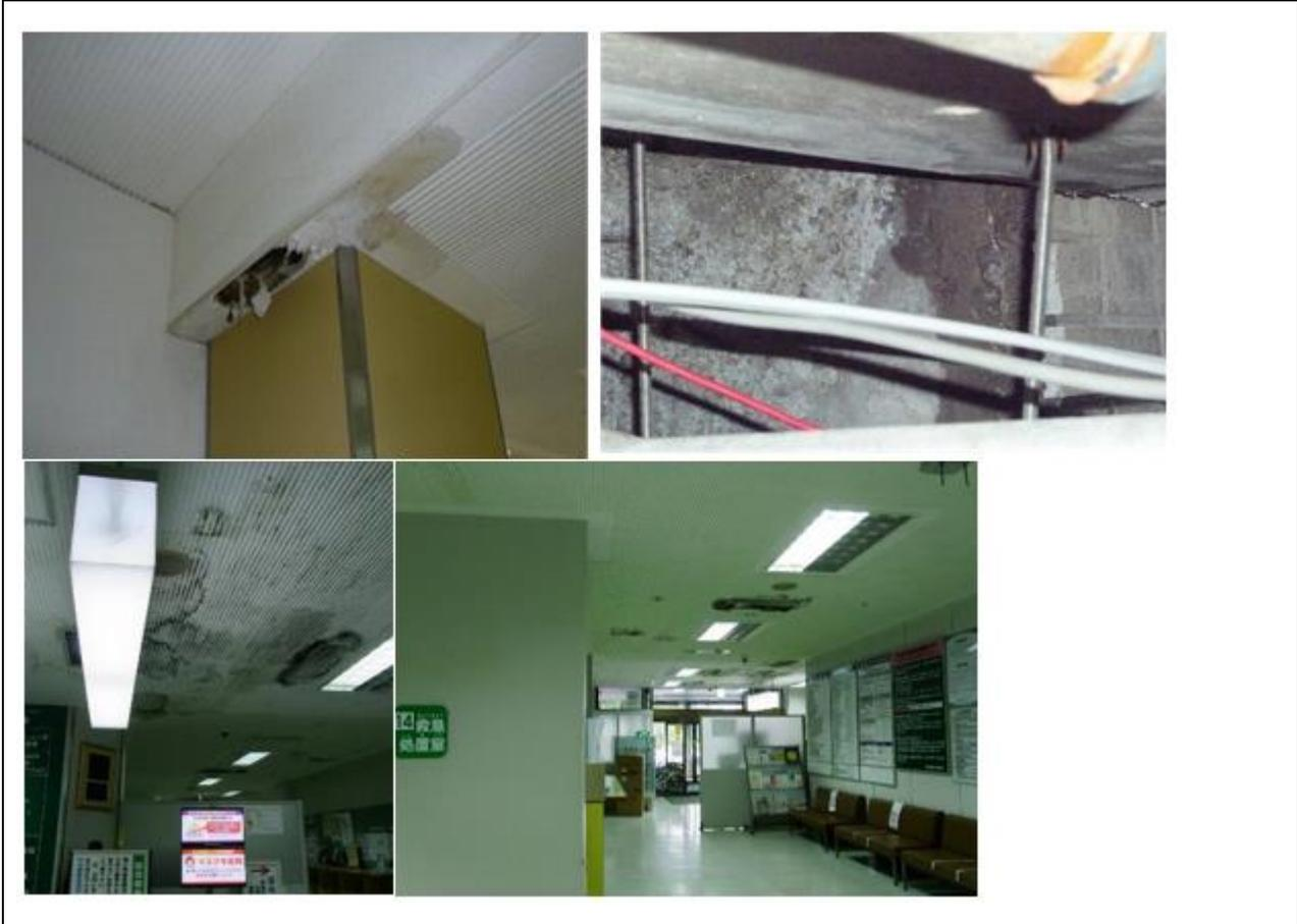
老朽化の内容 エントランスエキスパンションジョイント付近からの雨漏り
