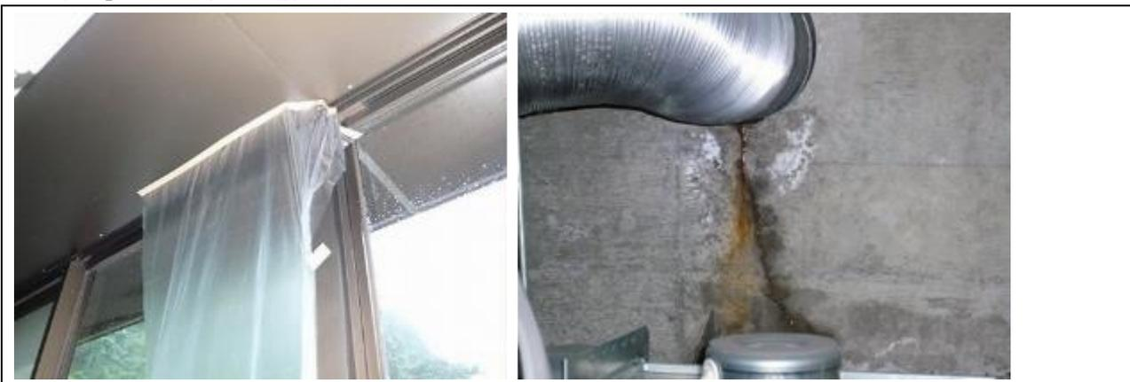
老朽化の内容：雨漏り（外壁ひび割れあり）
