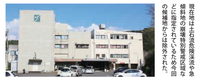
●肝属郡医師会立病院（肝属郡錦江町神川 135-3） 1981年開設。地上4階建、病床数196床、診療科12科（内科、脳神経内科、外科、泌尿器科、循環器内科、呼吸器内科、糖尿病内科、肝臓内科、血液内科、消化器内科、整形外科、眼科）
