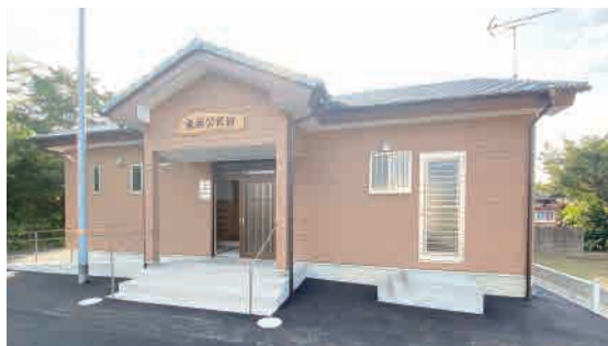
令和2年度コミュニティセンター助成事業を活用して建設
