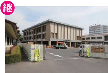
2019年6月完成予定の錦江町総合交流センター（建設中）
