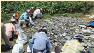
第7陣の際の瓦撤去作業の様子
