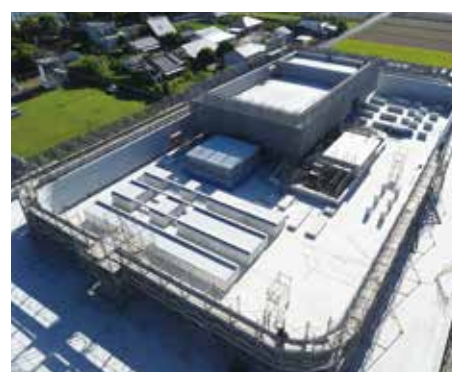
▲ 4階屋根エリア
