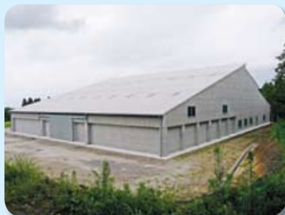
建設中の土づくり支援センター (錦江町神川、町総合運動公園先)
