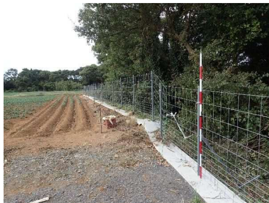
イノシシ侵入防止柵
