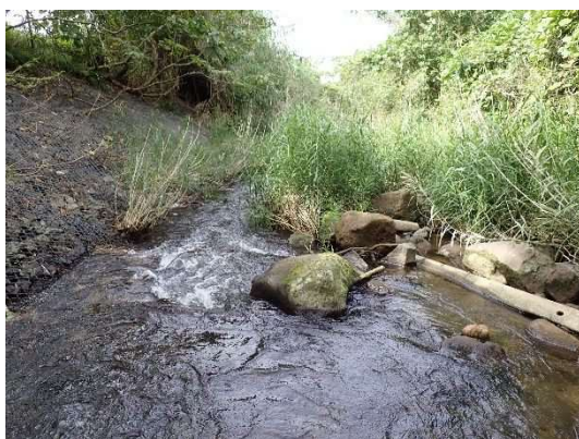
石張護岸（水流川）
