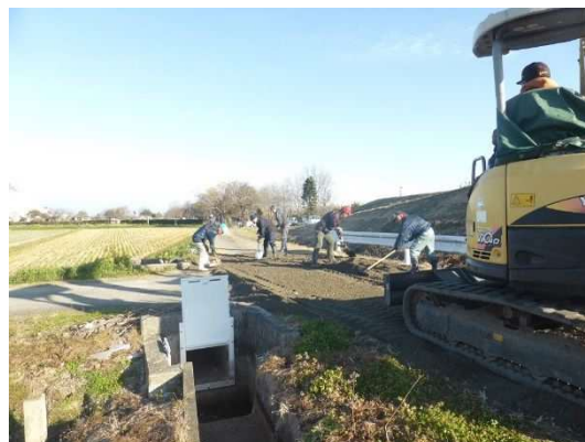
農道路面補修作業
