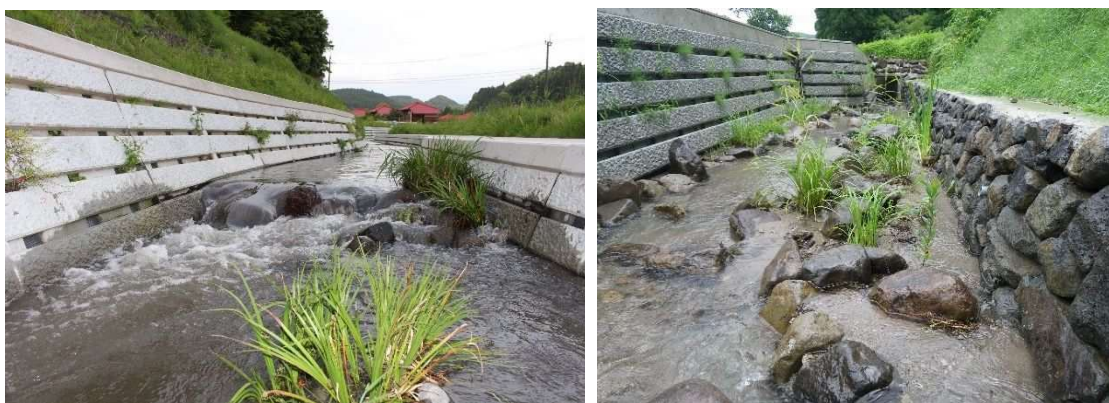
環境配慮型水路の例
