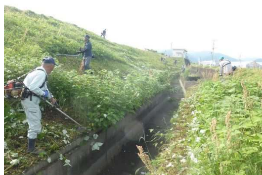
水路法面の草払い活動
