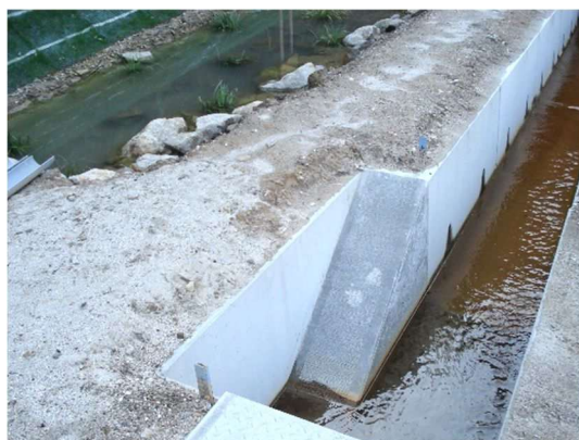
脱出スロープ付側溝
