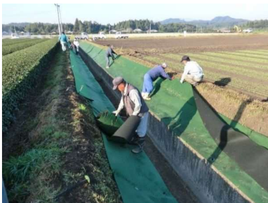
排水路法面防草対策作業
