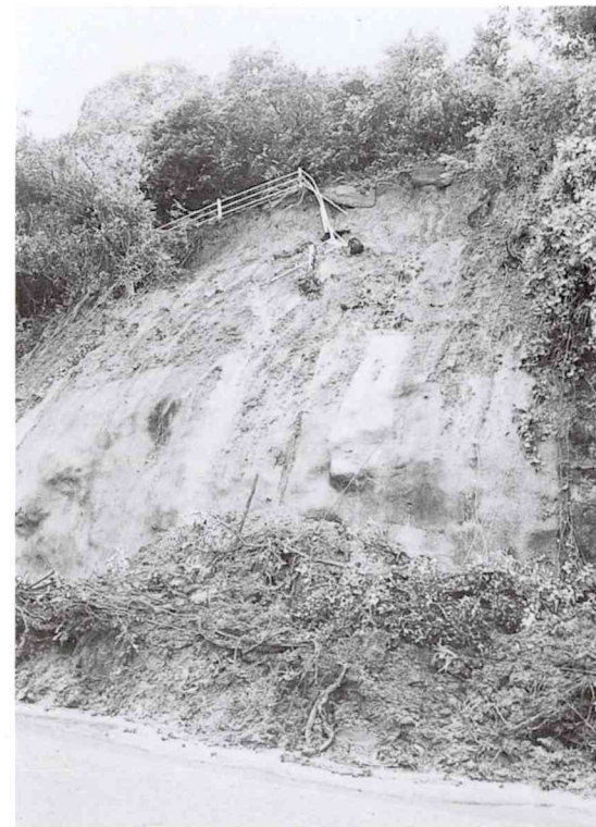
国道269号線（皆倉付近）
