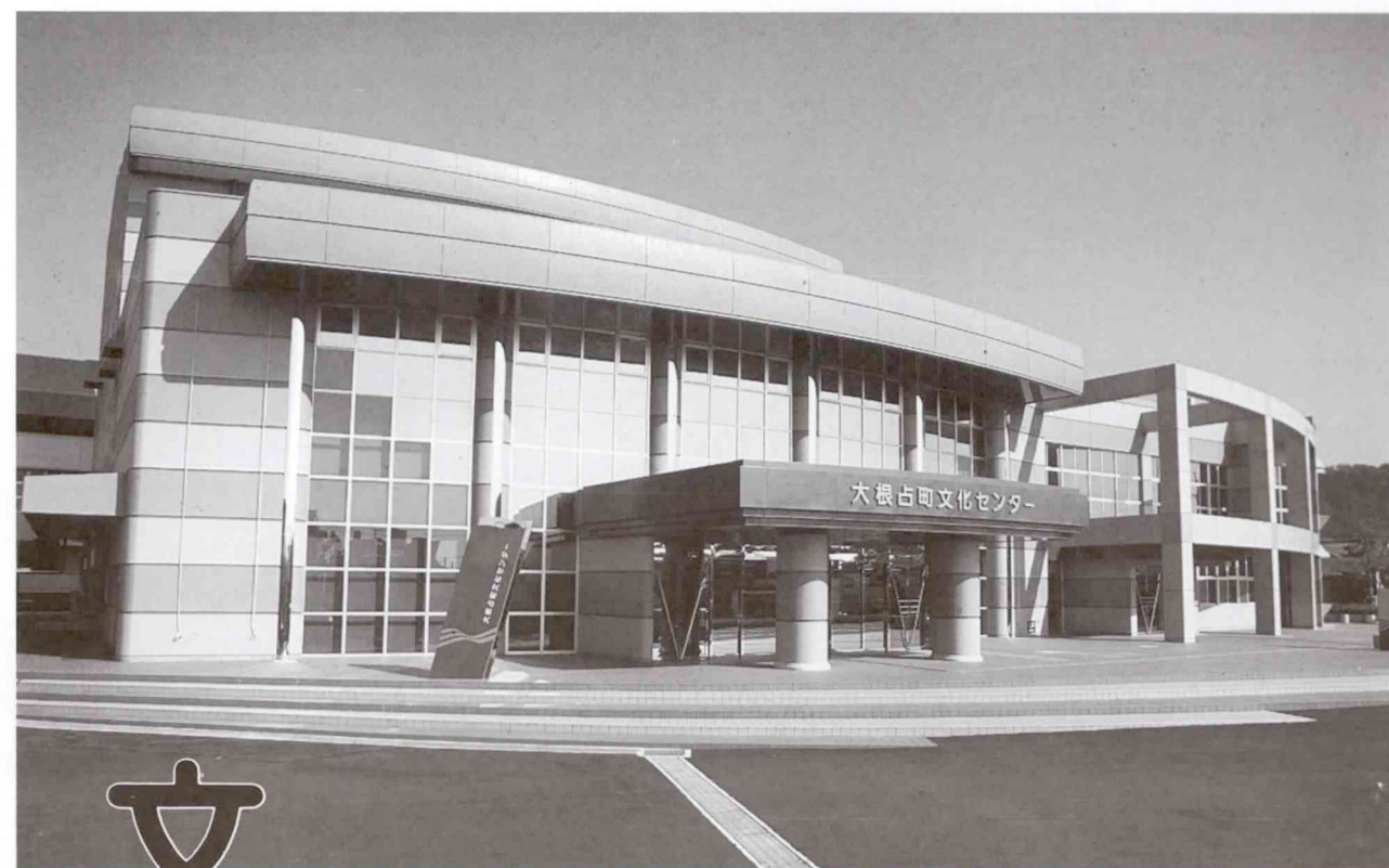
▶大根占町文化センター(正面より)
