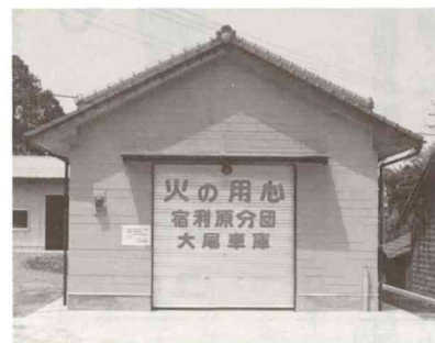
建設された大尾の消防車庫
