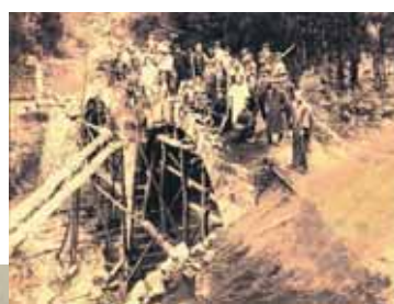
建設中の橋の上で→
