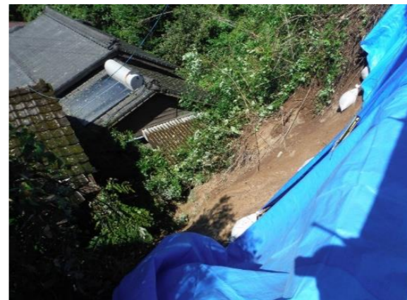
霧島市国分川原地内 毛梨子野地区で発生した がけ崩れ(令和4年9月)
