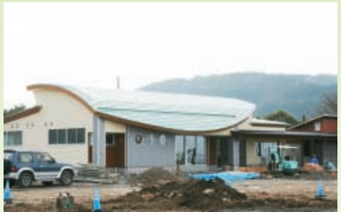
現在建設中の「錦江町物産館 にしきの里」
