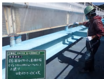
補修状況 (塗装工)
