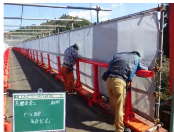
補修状況 (高欄設置工)
