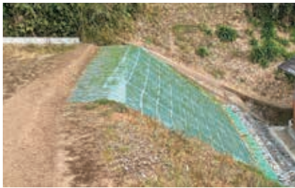
法面の復旧工事
