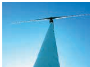
巨大な風力発電設備 (南大隅ウインドファーム)
