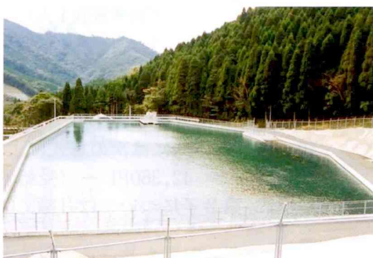
半ヶ石調整水槽
