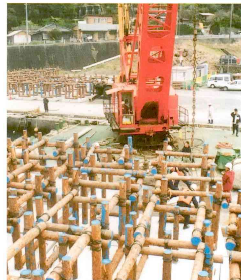
完成した漁礁の積み込み
