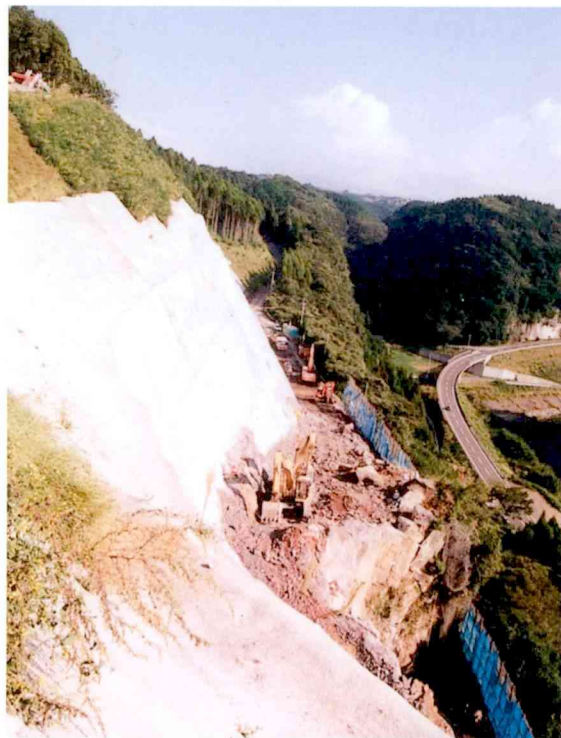
難工事が急ピッチで進められます。
