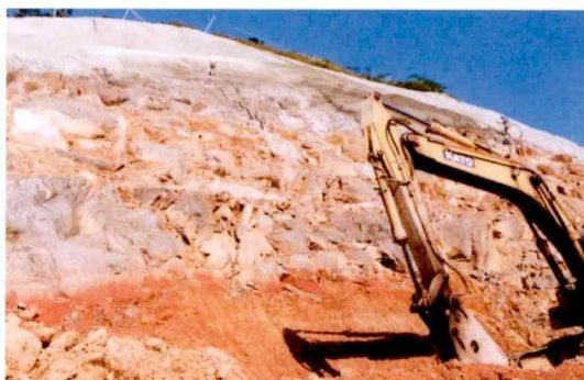
モルタル吹き付け作業
