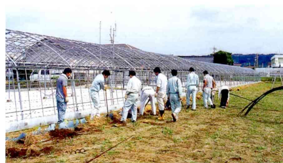
ハウス解体の事業収入
