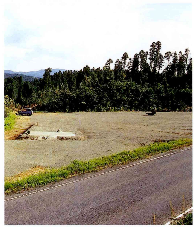
田代町の建設現場の様子
