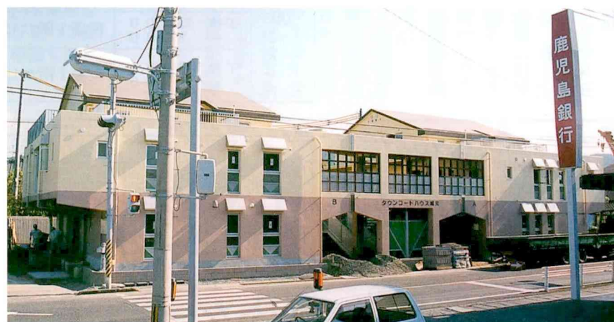
完成間近のタウンコートハウス城元団地
