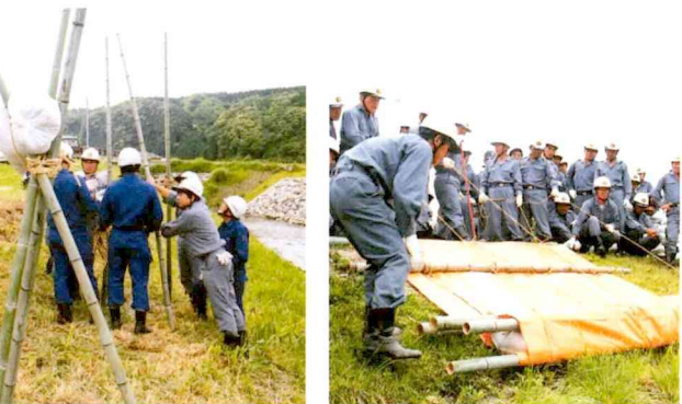
シート張り工法
