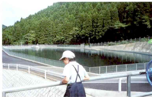
池田（半ヶ石頭首工）
