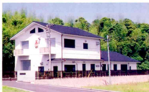
麓地区浄化センター
