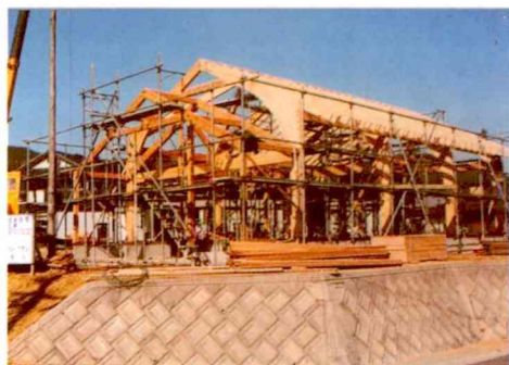
元気おこし「昇陽団地E棟」建築中
