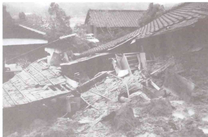
鶴園地区被災現場
