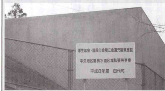
中村上原配水池
