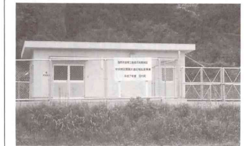
永田ポンプ場
