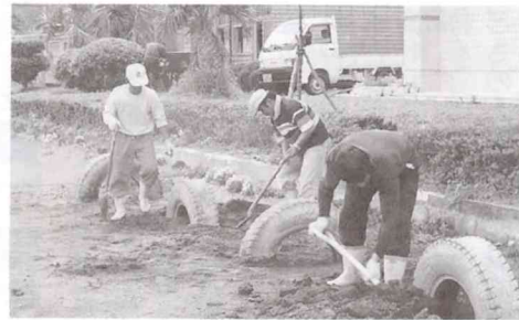
タイヤの埋め込み作業
