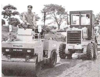
整地作業をするPTA機動部隊
