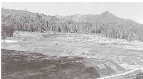
完成間近の宅地造成地
