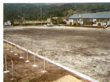
排水溝も整いました
