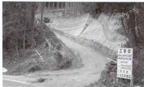
林道横掘線開設
