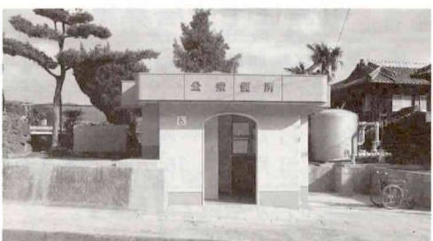
改装された中央公衆便所
