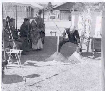
役場庁舎着工
