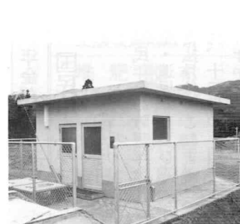
池野ポンプ場
