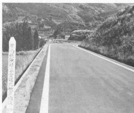
鳥淵、瀬戸口線改良舗装工事
