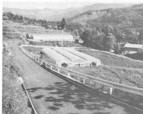
桑木迫地区農道整備工事
