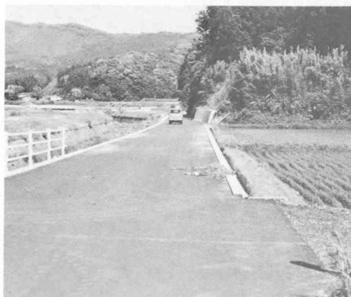
中崎、表木線改良舗装工事
