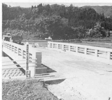
椎木橋架換え工事(負担金)
