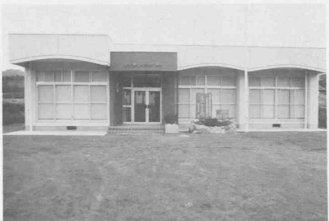
完成した表木農業研修センター
